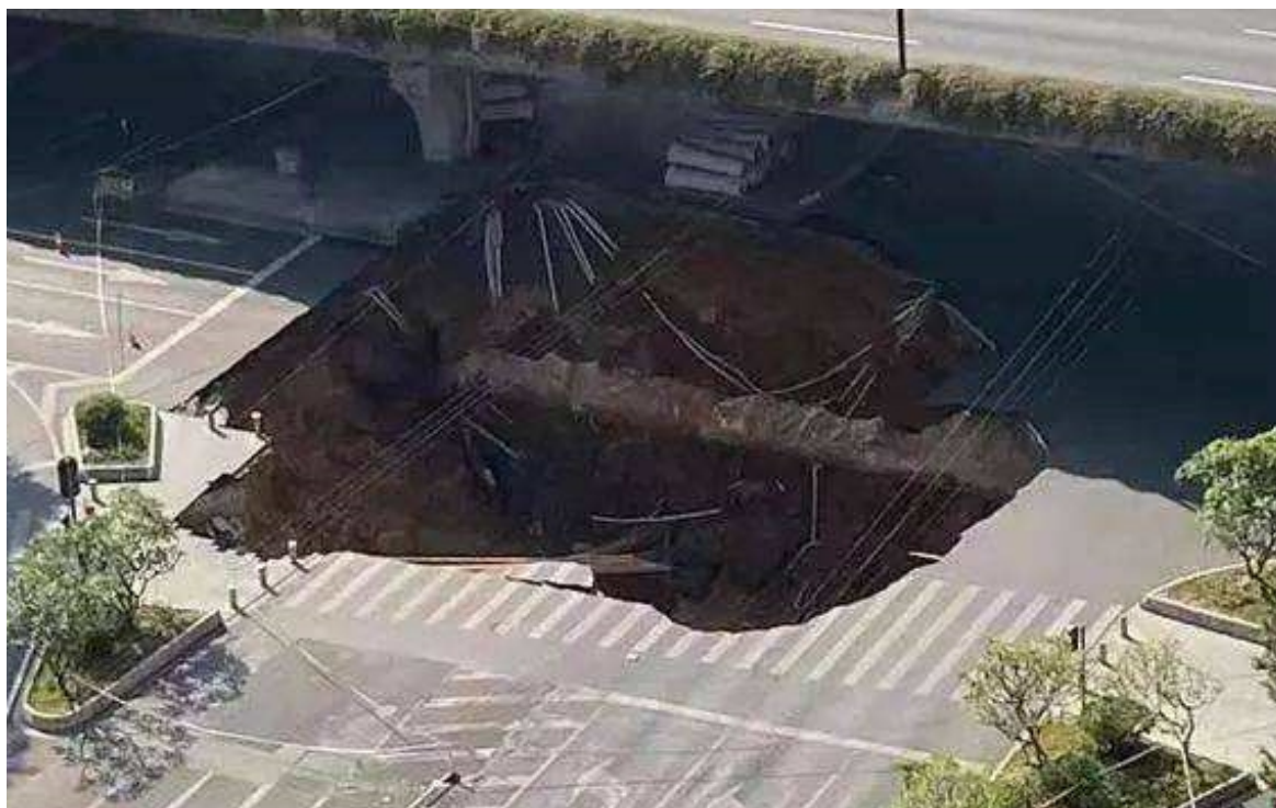
图示:地面塌陷区航拍照片
