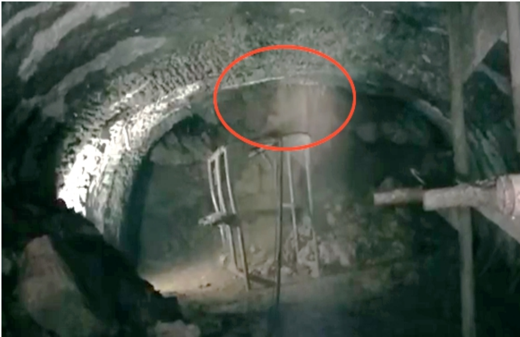
图示：掌子面拱顶突泥涌砂视频截图
