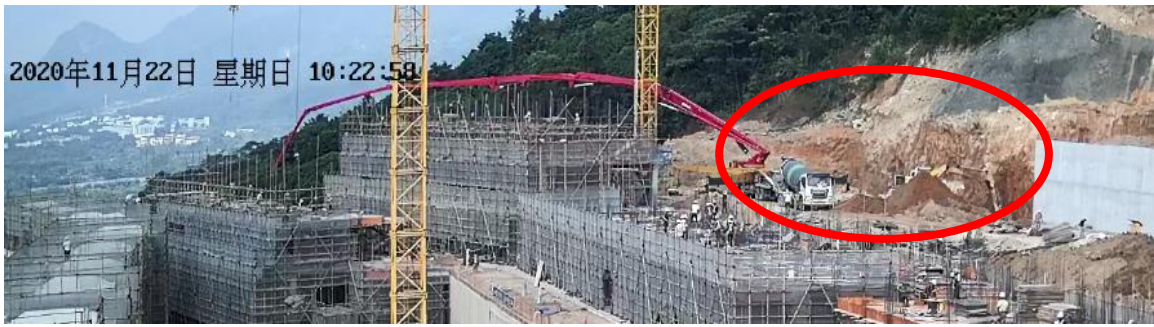
图 12 挖掘机在开挖基槽
