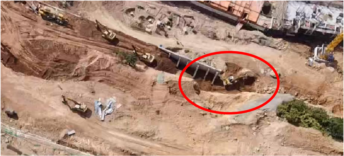
图 10 挖掘机在向挡土墙后方转运土石
