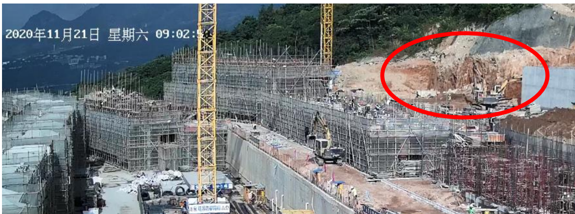
图 11 挖掘机在开挖基槽
