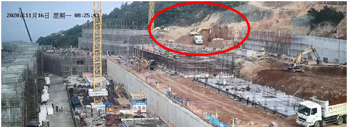
图 6 挖掘机在开挖山体
