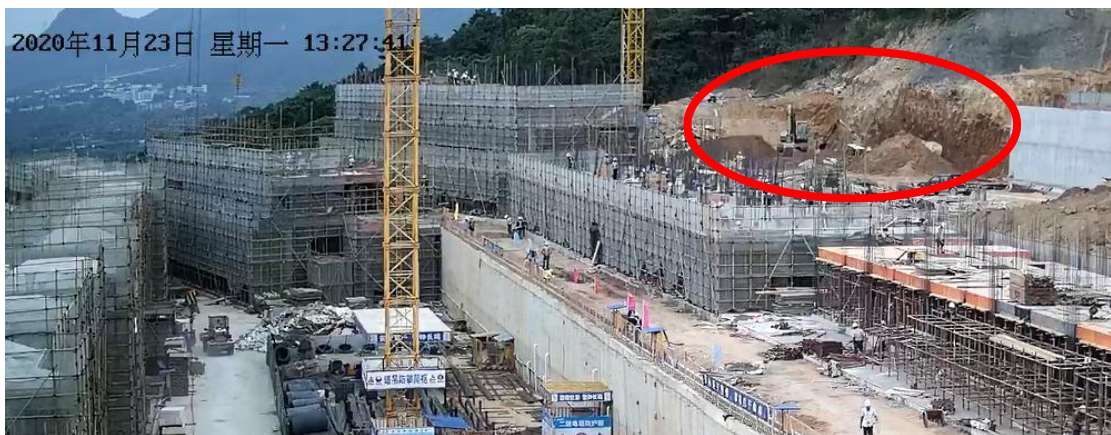
图 14 挖掘机在开挖基槽
