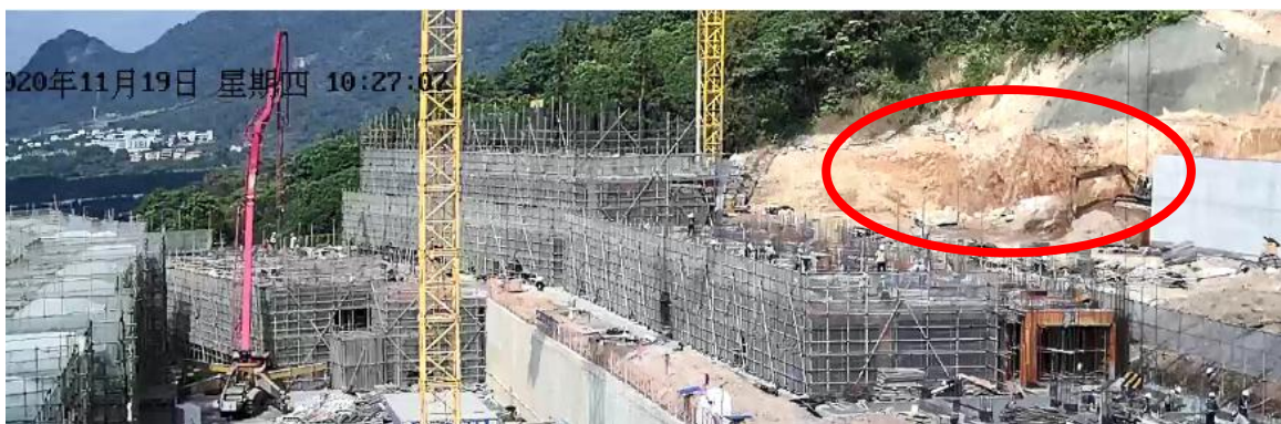
图 9 挖掘机在向挡土墙后方转运土石
