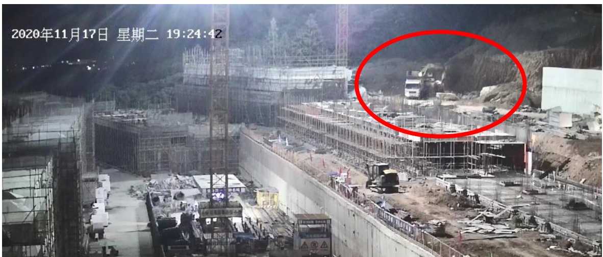
图 7 挖掘机在夜间开挖山体
