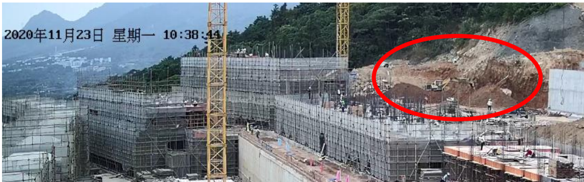
图 13 挖掘机在开挖基槽
