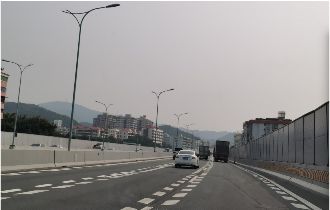
图6 事故路段复勘图
