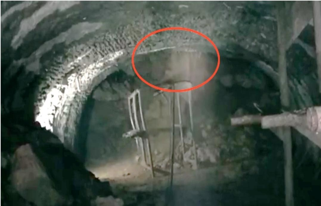
图示：掌子面拱顶突泥涌砂视频截图
